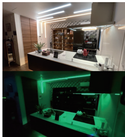
「蓄光機能搭載LEDフレキシブルライト」の施工例
